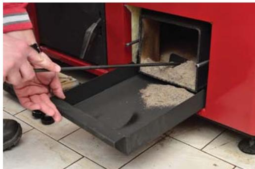
7. После чистки и установки дверцы на штатное место убедитесь, что винты на дверцах хорошо закручены, или в противном случае котел не будет греть воду должным образом.
